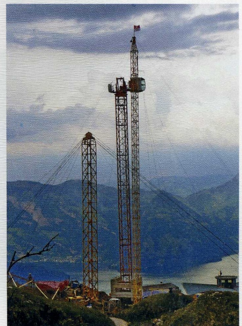
Materialeilbahn, Turmdrehkran, Montagenadel.
