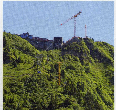
Restaurant, Bergstation und Baustelle auf dem Stanserhorn.
